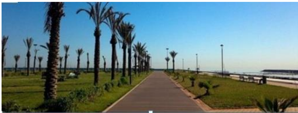
Figure 14. Aménagement réalisé sur la promenade des sabelettes côté embouchure d'oued El Herrach.
