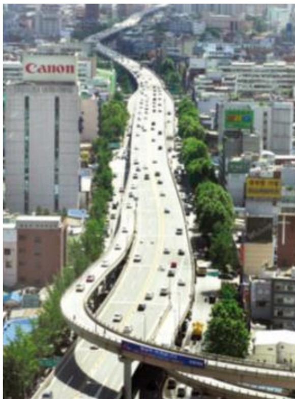
Figure 4. Le site de la rivière après la construction de l'autoroute (source : Agence d'urbanisme pour le développement de la région lyonnaise, 2009).
